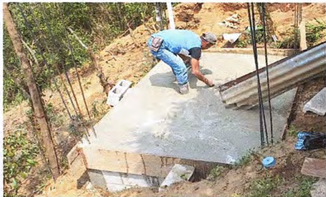
Foto 1: Mejoramiento general de sanitario y fosa séptica
