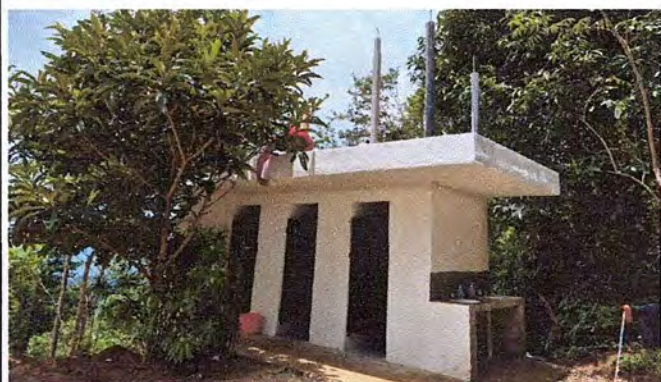
Foto 3: Mejoramiento general de sanitario y fosa séptica
