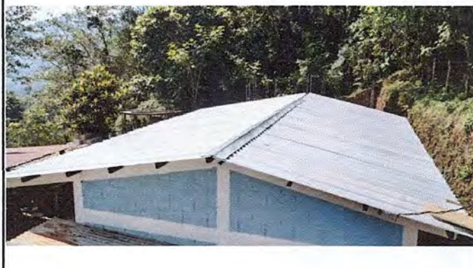
Foto 4: Mejoramiento y estructura de techado.
