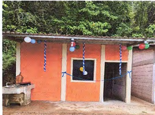
Foto 2: Reparación y mejoramiento general de cocina.
